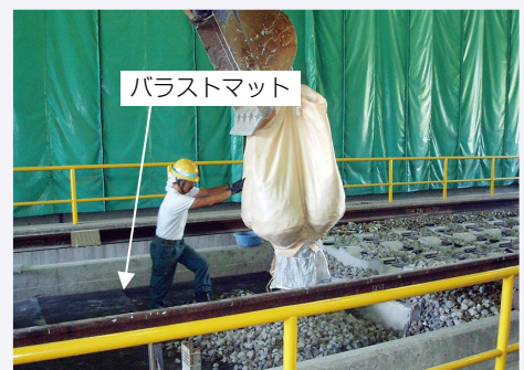
図7 バラストマット (バラストの下に弾性材のマットを敷設)
