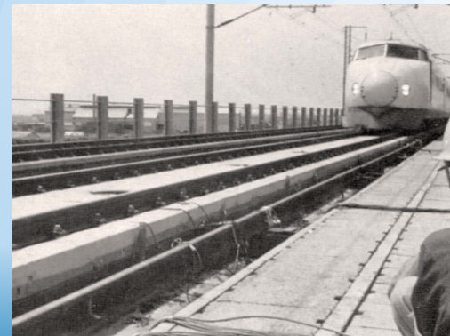
1975 軌道保守の省力化をはかるため開発されたスラブ軌道
