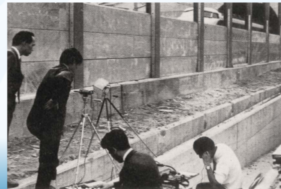
列車走行による騒音を吸収する吸音型防音壁の効果確認試験
