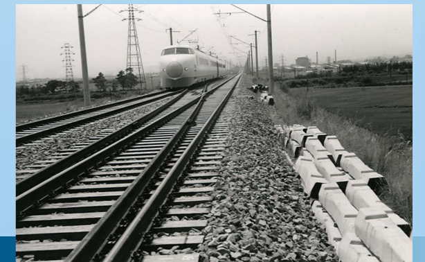
鴨宮モデル線を走る試験車両B編成 新幹線用に開発されたPCまくらぎ(線路脇)(1963年)
