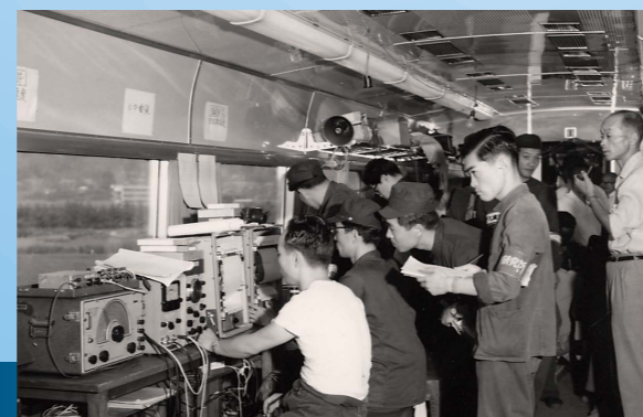
新幹線走行試験の車内測定
