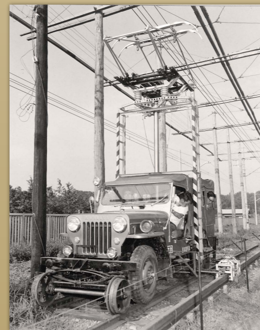
新幹線用架線試験
