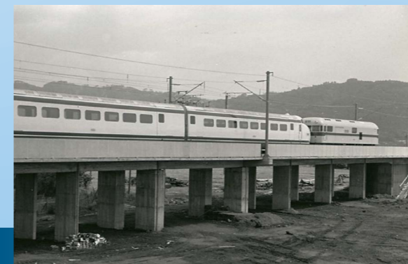
試験車両に牽引される4001(のちの921-1)軌道検測車(1962年)
