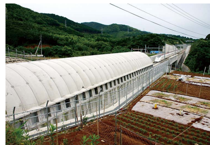
図2 トンネル入口緩衝工の例 1)
