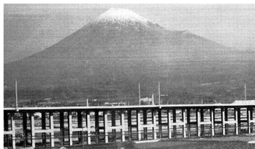
図2 中層梁のあるRC ラーメン高架橋 (出典: 文献1))
