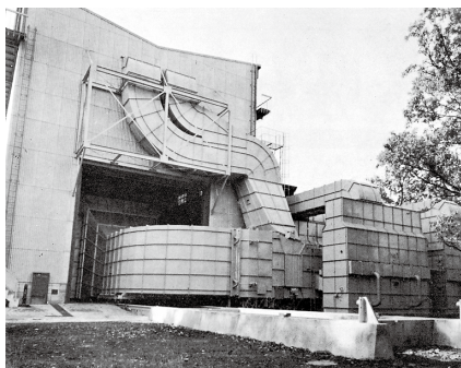
③完成した燃焼実験棟と送風排煙装置
