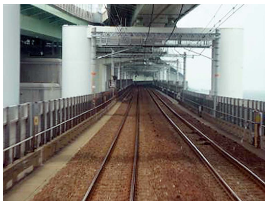
図1 線路両側に防風柵を設置(関西空港線連絡橋の例)
