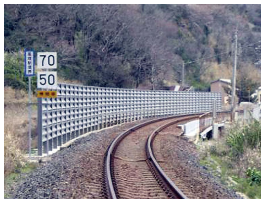
図2 線路片側に防風柵を設置(山陰本線掛戸橋りょうの例)
