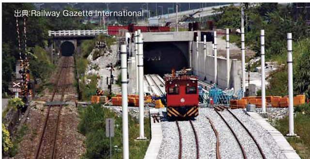
出典:Railway Gazette International Sikou トンネルを通る新路線で軌道と電化の工事が進む
