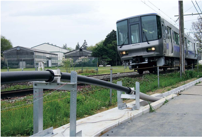
図3 超電導き電ケーブルによる電車の走行試験
