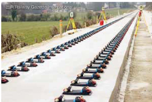
レールシートを設置して完成した軌道スラブ
