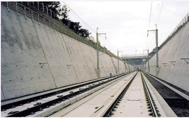
図8 土構造物上(切土区間)のA形スラブ軌道の外観
