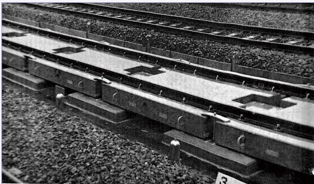
(a)敷設状況
