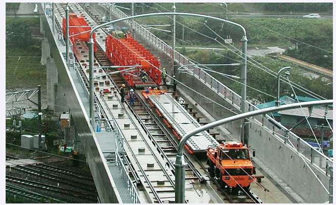
図9 軌道スラブの敷設状況
