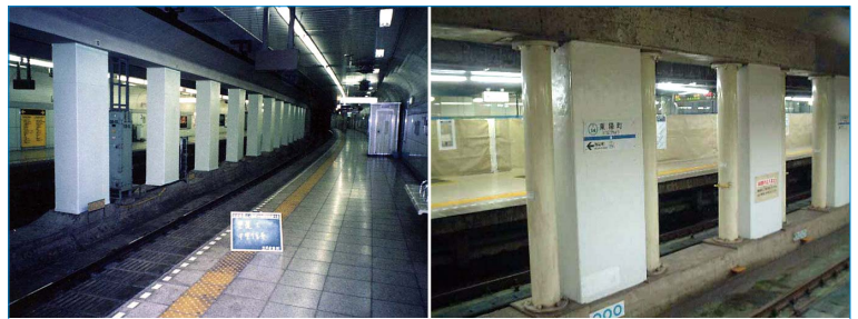
鋼板巻立て補強
