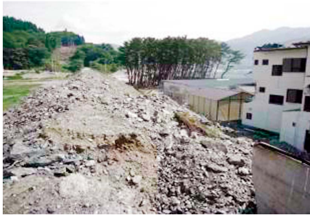
図10 軌道・路盤流出(三陸鉄道)
