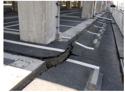
図9 高架橋無被害(京葉線)
