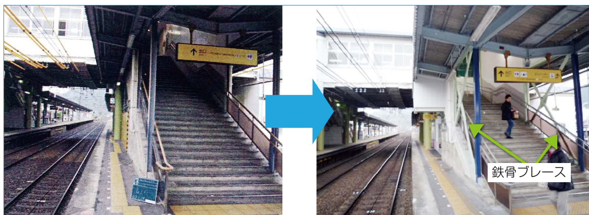
図3 橋上駅の耐震補強
