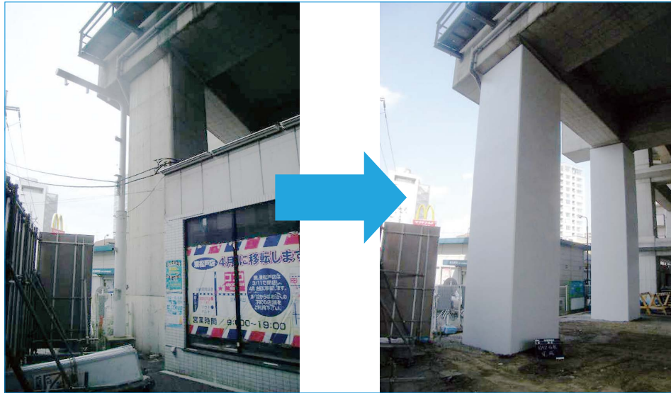
図1 高架橋の耐震補強
