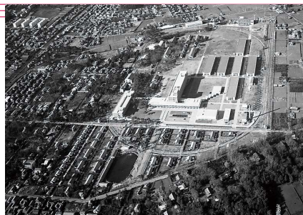
①国立研究所とループ線を、東側から西方向に撮影した航空写真で、東側の敷地には木造官舎が並んでいる(1963(昭和38)年1月31日撮影)
