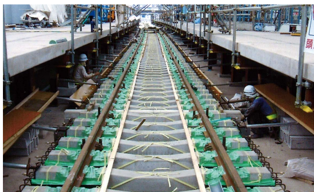
図1 D型弾直軌道の施工例（日暮里駅）
