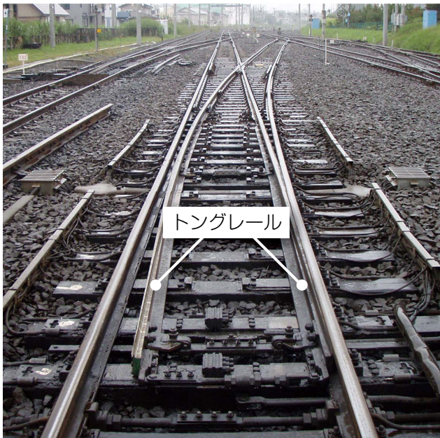
図1 トングレールの敷設状況
