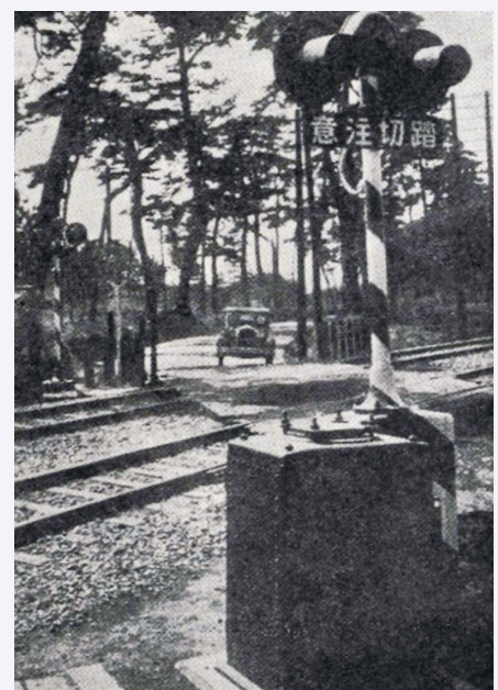
図6 電鈴閃光式踏切警報機 出典：日本国有鉄道百年史 1)
