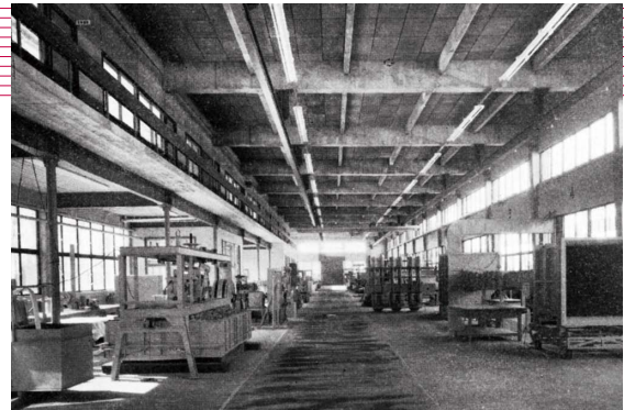
⑤完成時の実験棟の屋内
