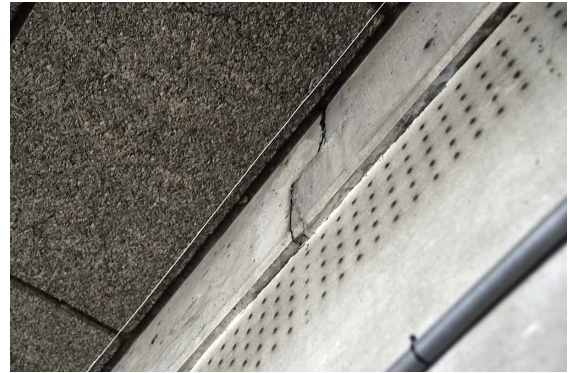
⑦小梁に見られるゲルバーの継手部分
