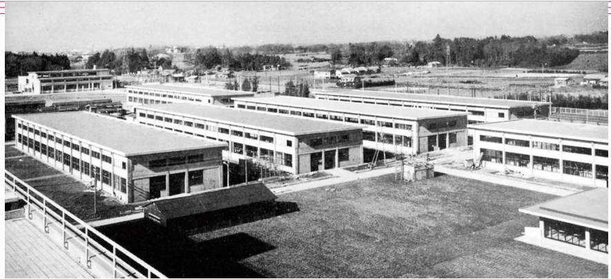
①完成した実験棟群
