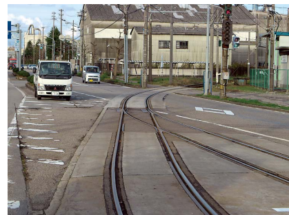
図4 レールの周囲のみアスファルト舗装
