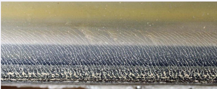
図5 きしみ割れ(熱処理レール)
