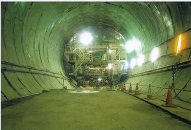
図7 東北新幹線三本木原トンネルにおける SENS工法による施工 出典：RRR, Vol.68, No.3, 2011
