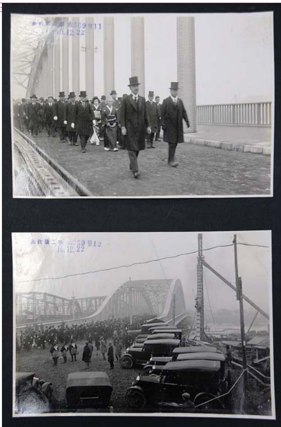
⑤永代橋の渡り初め(1926(大正15)年12月22日) 所蔵：東京大学
