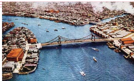
①帝都復興事業で完成した隅田川の清洲橋
