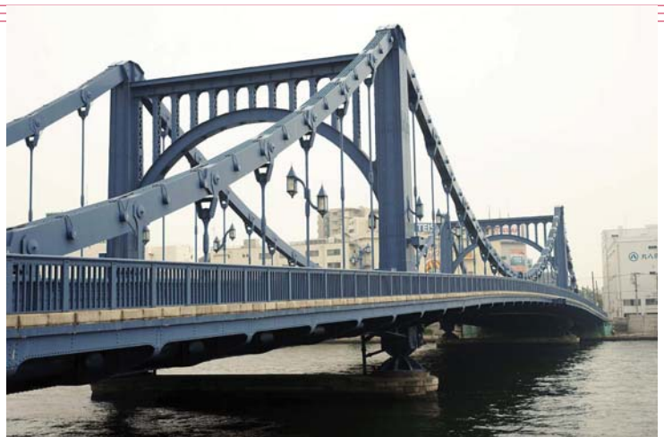
⑥現在の清洲橋(国指定重要文化財)
