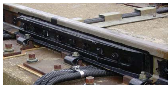
図4 現地敷設状況
