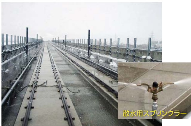
図1 散水消雪方式
