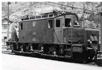
②シンプロントネルの電気機関車 (所蔵：鉄道総研島文庫)
