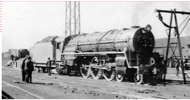
⑥南アフリカの16E形蒸気機関車（所蔵：鉄道総研島文庫） 南アフリカは、日本と同じ狭軌鉄道であったが、日本の蒸気機関車よりもひと回り大きく、動輪径は1830mmを誇った。
