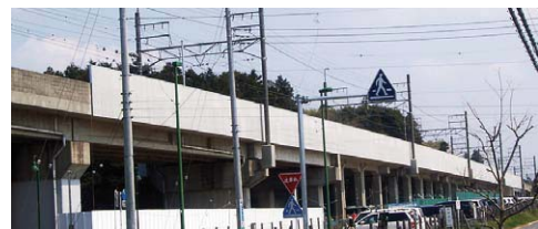
図2 高さ上げ後の外観（左端はかさ上げ施工前）
