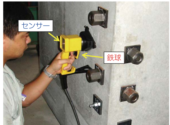
図8 インパクトエコー法による測定
