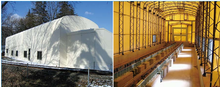
図2 高周波車両加振試験装置の外観と内部
