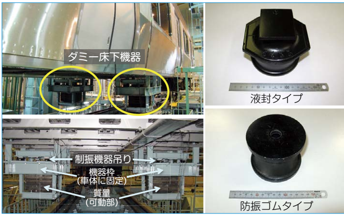
図3 ダミー床下機器の設置状況と製作した制振機器吊り
