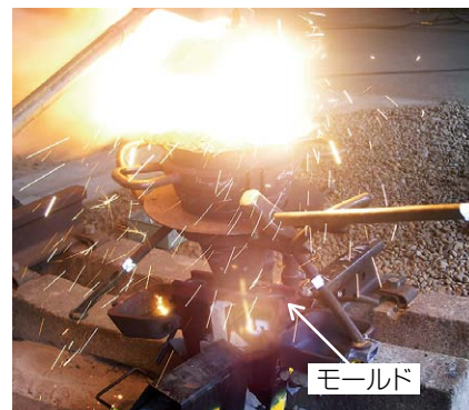
図1 ゴールドサミット溶接
