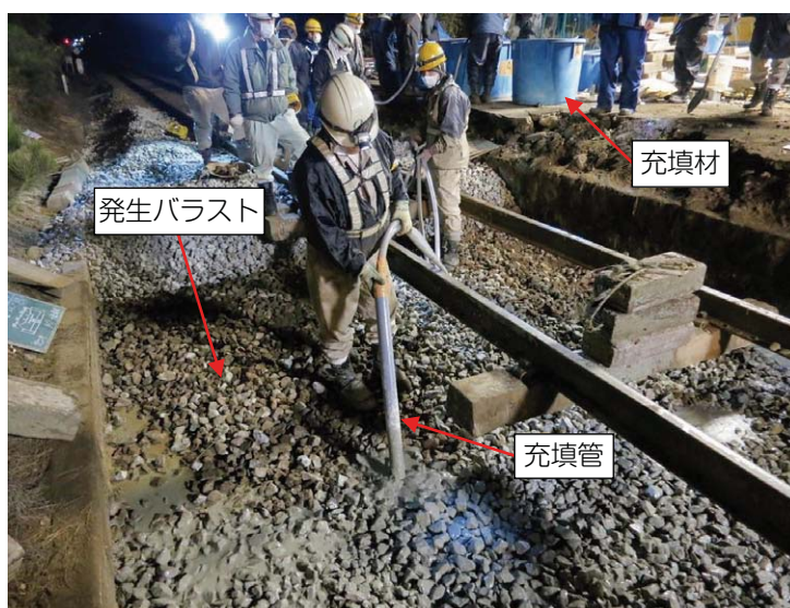
図 新しい路盤改良工法の概要(グラウト充填状況)
