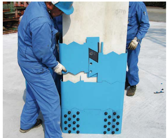
図8 波型分割鋼板巻立て補強
