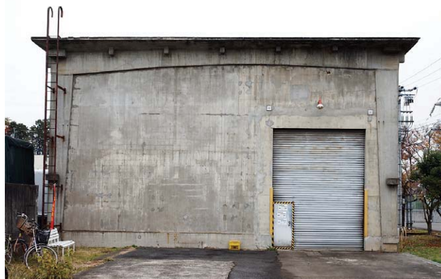
⑤妻面に露出した門型ラーメンのPC構造
