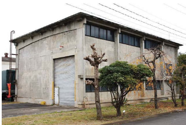
④現在の旧ボイラー室
