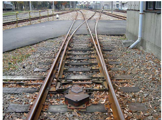
図2 側線用8番分岐器 (鉄道総研内)
