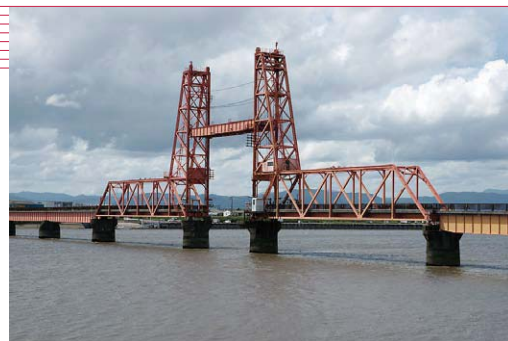
④現在の筑後川橋梁（国指定重要文化財）
