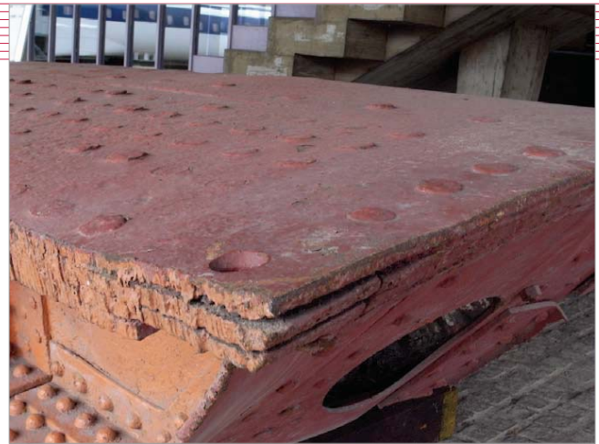
④皿リベットを用いた表面の仕上げ：外側は、地山との摩擦を軽減するため、皿リベットを用いて平滑に仕上げた。
