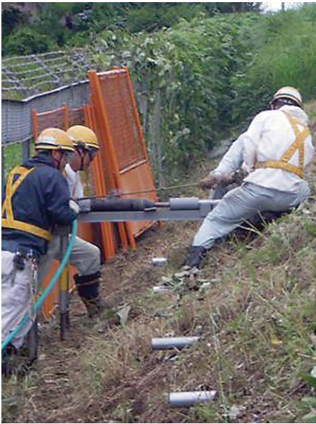
図2 盛土に打設される排水パイプ
