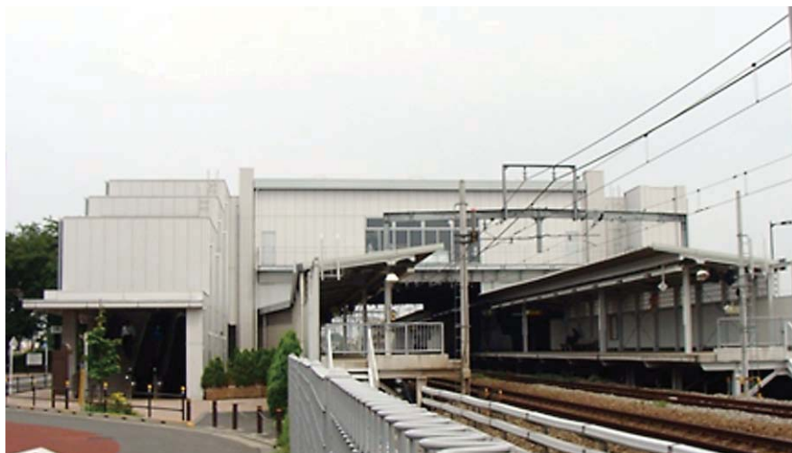
図1 線路上空建築物(橋上駅)
