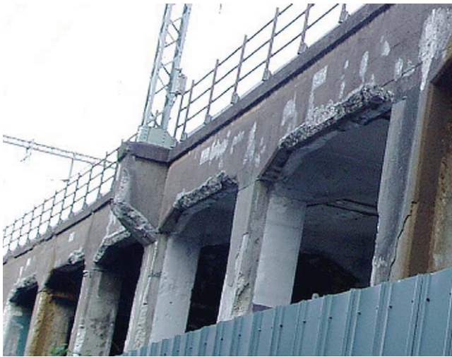
図10 補強前のラーメン高架橋
