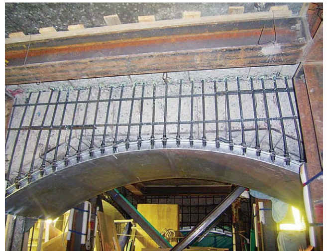
図11 補強工事中の状況
