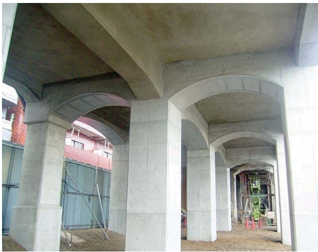
図12 補強後のラーメン高架橋
