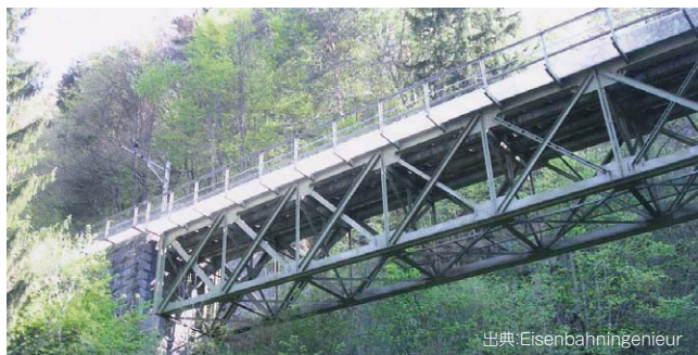
ブリュニク線のリベット鋼橋
