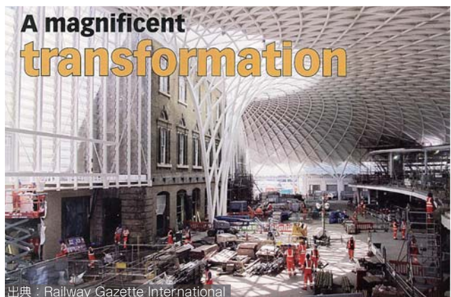
改築の中心的構造物である長大スパンの屋根と漏斗状の支柱
