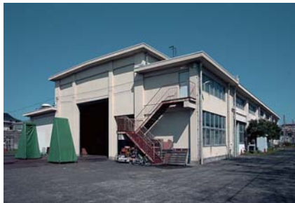
⑦現在の旧車両試験台の外観
