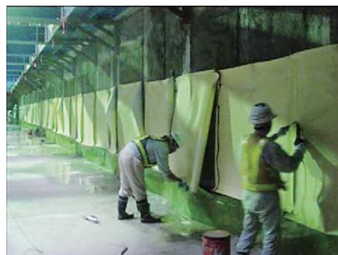
図2 側部先防水(側部シートと導水シート施工状況)
