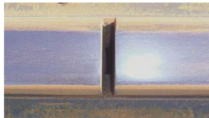
(b)施工直後の頭頂面外観
