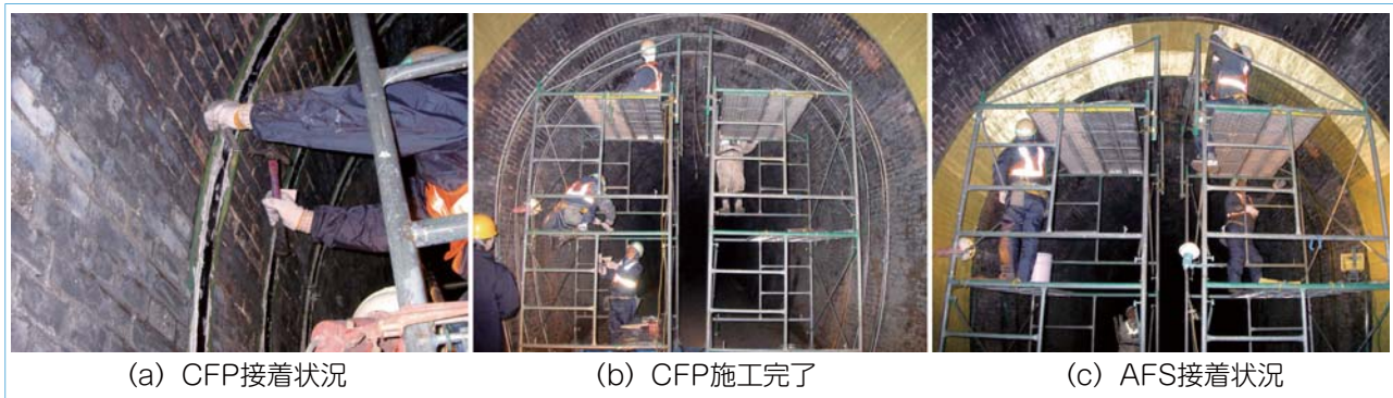
図9 試験施工の状況
