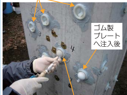
ゴム製プレートへ注入中
