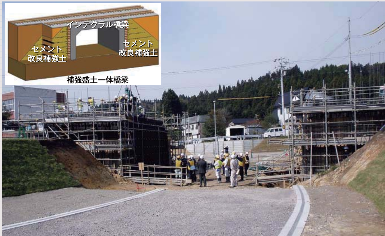
補強土を併用したインテグラル橋梁(補強盛土一体橋梁)は、これまで鉄道分野で実績があるRRR工法の技術を橋梁分野まで応用した新しい橋梁技術です。支承部を省略し、自立性の高い補強盛土と従来のインテグラル橋梁を一体化することで、高い耐震性を有する構造物となりました。現在、(独)鉄道・運輸機構からの委託研究により、北海道新幹線木古内付近の実橋梁の動態計測を行っています。
