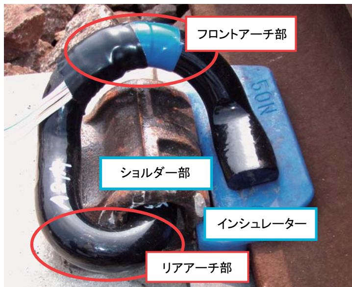
図 線ばね形レール締結装置の例と各部の名称
