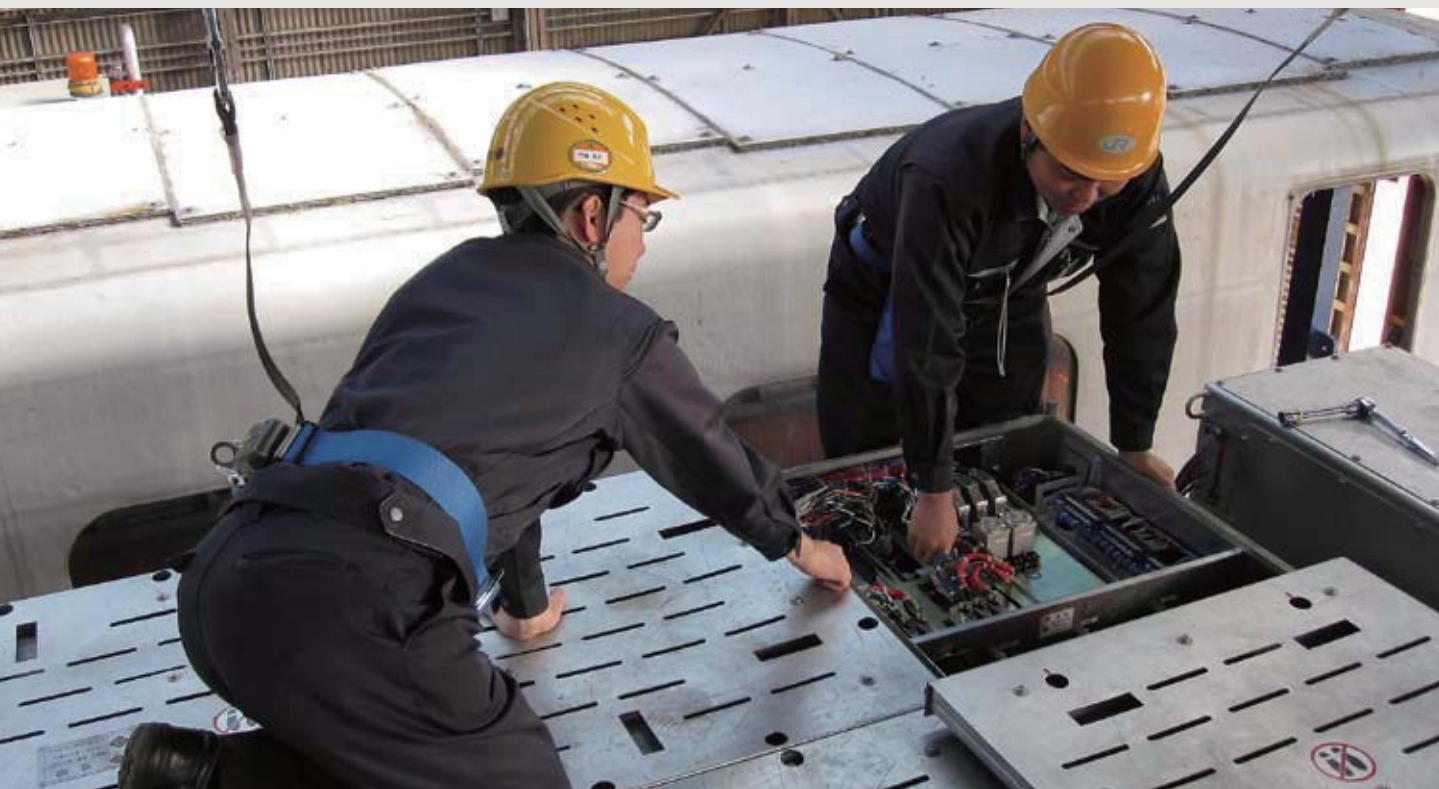
Hi-tramの電力変換器を点検しているところです。電磁機器や大電流急速充電器を含む電力変換器を1パッケージ化して小型化に成功し、小さなLRT車両の屋根上への搭載を実現しました。
